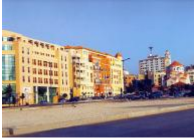
استخدام الطينة الملونة ( GFG ) بالإكساء - بيروت
