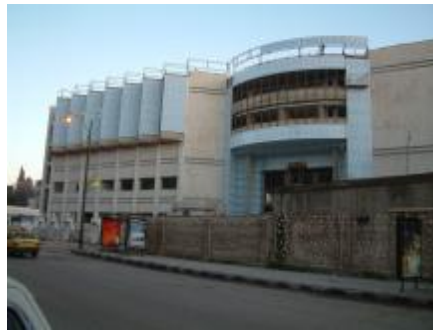
خطأ في الدراسة المعمارية يبدو من خلال التناثر في مواد الإكساء بين الحجر والألومات - حمص -
