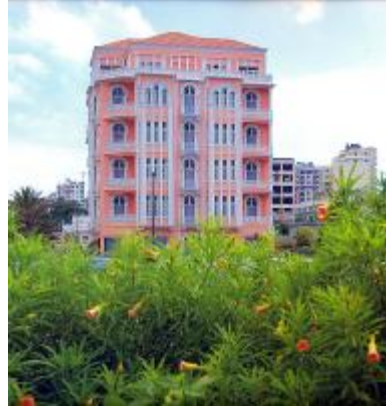
إكساء المبنى بالطينة الملونة وتنفيذ الأفاريز والكورنيشات بمادة GRC - بيروت
