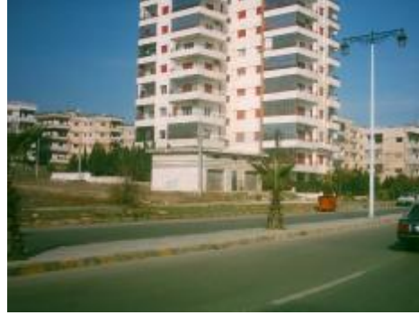
مراعاة المصمم لوظيفة المبنى السكنية وعدم إعطاء مساحات زجاجية كبيرة (ستر الشرفات تصريفات فردية) - حمص
