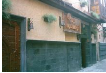
إن إكساء المبنى بمواد تعطي إحياء القديم للانسجام مع د المحيط العمراني (حجر - GRC - خشب) دمشق القديمة
