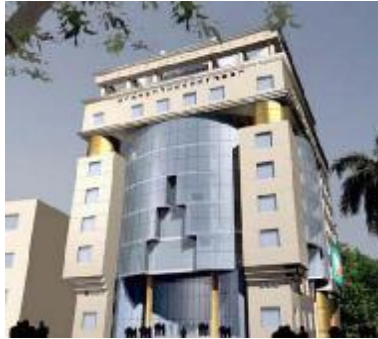
تميز وظائف المبنى من خلال التمايز في مواد الإكساء - مبنى مكاتب - الإمارات
