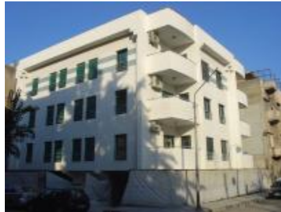
استخدام الحجر الصناعي للإكساء - حمص
