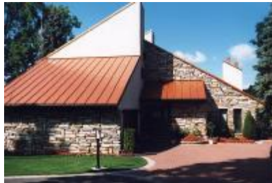
استخدام القرميد الصناعي بالإكساء الخارجي
