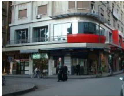
تصرف الشاغل أو المالك بإكساء جزء من المبنى نتيجة غياب التشريعات اللازمة أدى إلى ظهوره بشكل غريب عن المحيط العمراني
