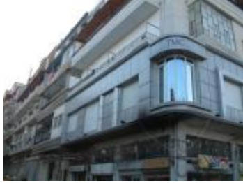
مبنى سكني تم إكساء جزء منه (إدارة الشركة) بالمعدن (أكومات معدنية) كنوع من التمييز الوظيفي - حمص
