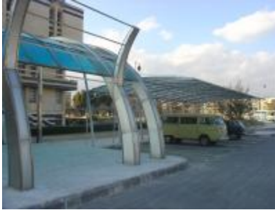
استخدام المايكرولولوكس في إكساء المظلات - جامعة البعث -
